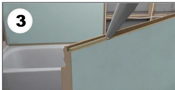
Appliquez du ruban de masquage sur les deux bords de la face décorative pour protéger le stratifié. Appliquez un cordon étroit (2-3 mm) de mastic silicone sur le support avant de la languette.
