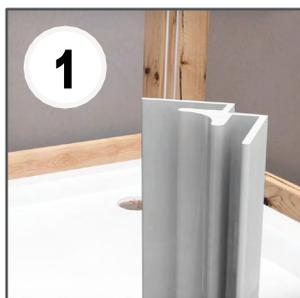
1 Le premier profilé, soit un coin intérieur de Type A ou un embout de Type C, doit être fixé au mur ou au sol aux extrémités avec des vis à tête fraisée, ou de la colle et un cordon de mastic silicone appliqué dans le creux du profilé.
